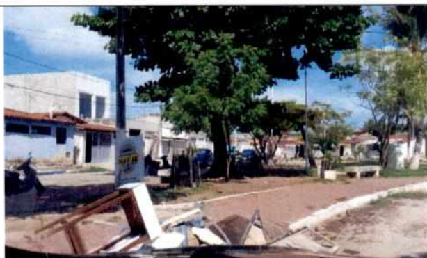
Praça da Palmeira, o outro bem público a que a Projecta se obrigou a construir e urbanizar de acordo com a Lei Municipal nº 1.651/2013.
